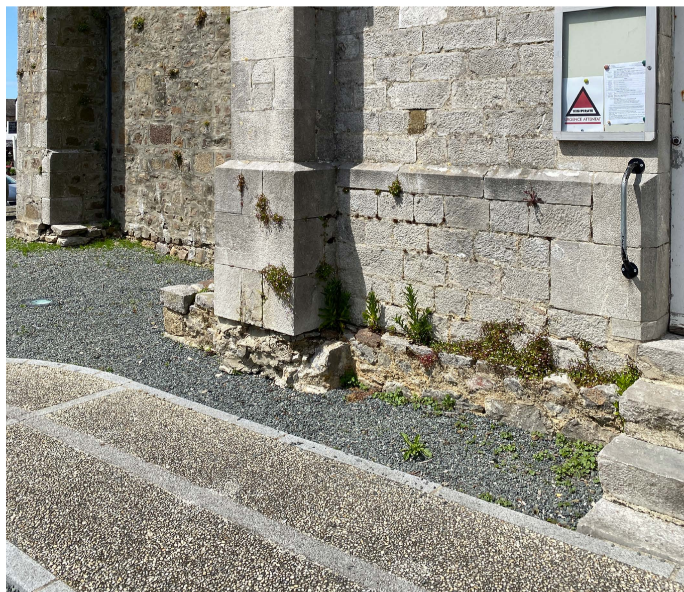
Photographie d'un pied de façade de l'Eglise, façade sud. Oblò architecture et patrimoine, mai 2024.
