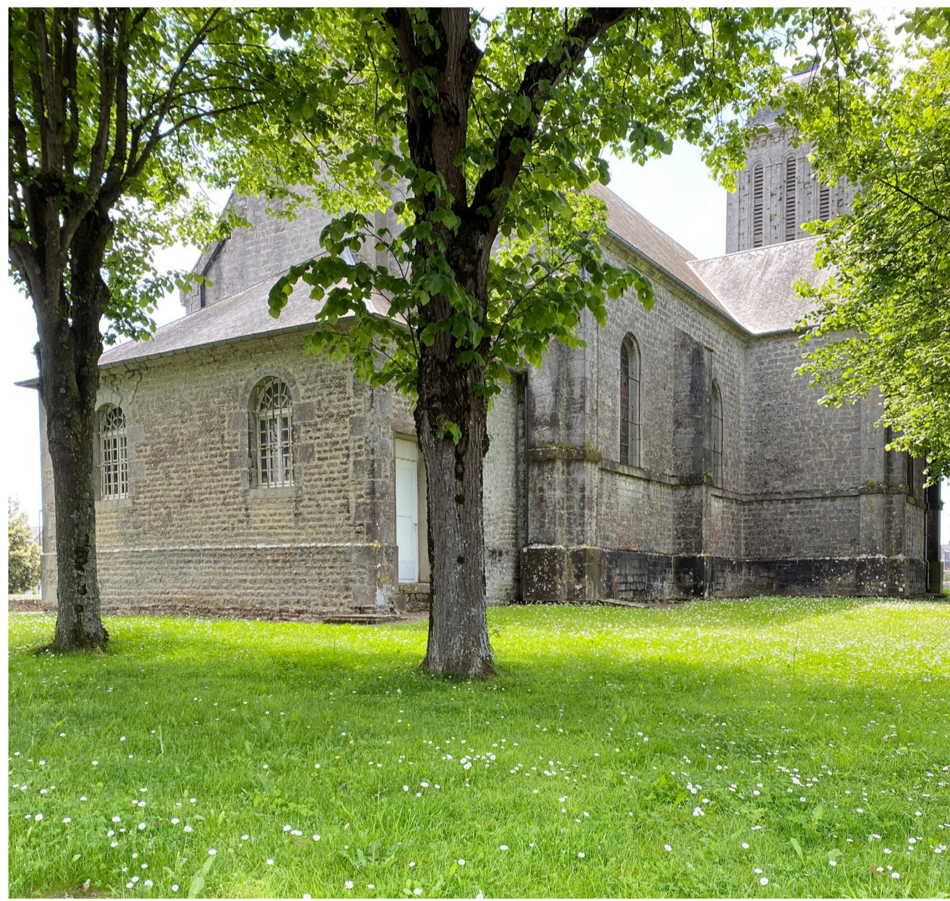
Photographie de l'Eglise, vue depuis l'ancien cimetière à l'Est. Oblò architecture et patrimoine, mai 2024.
